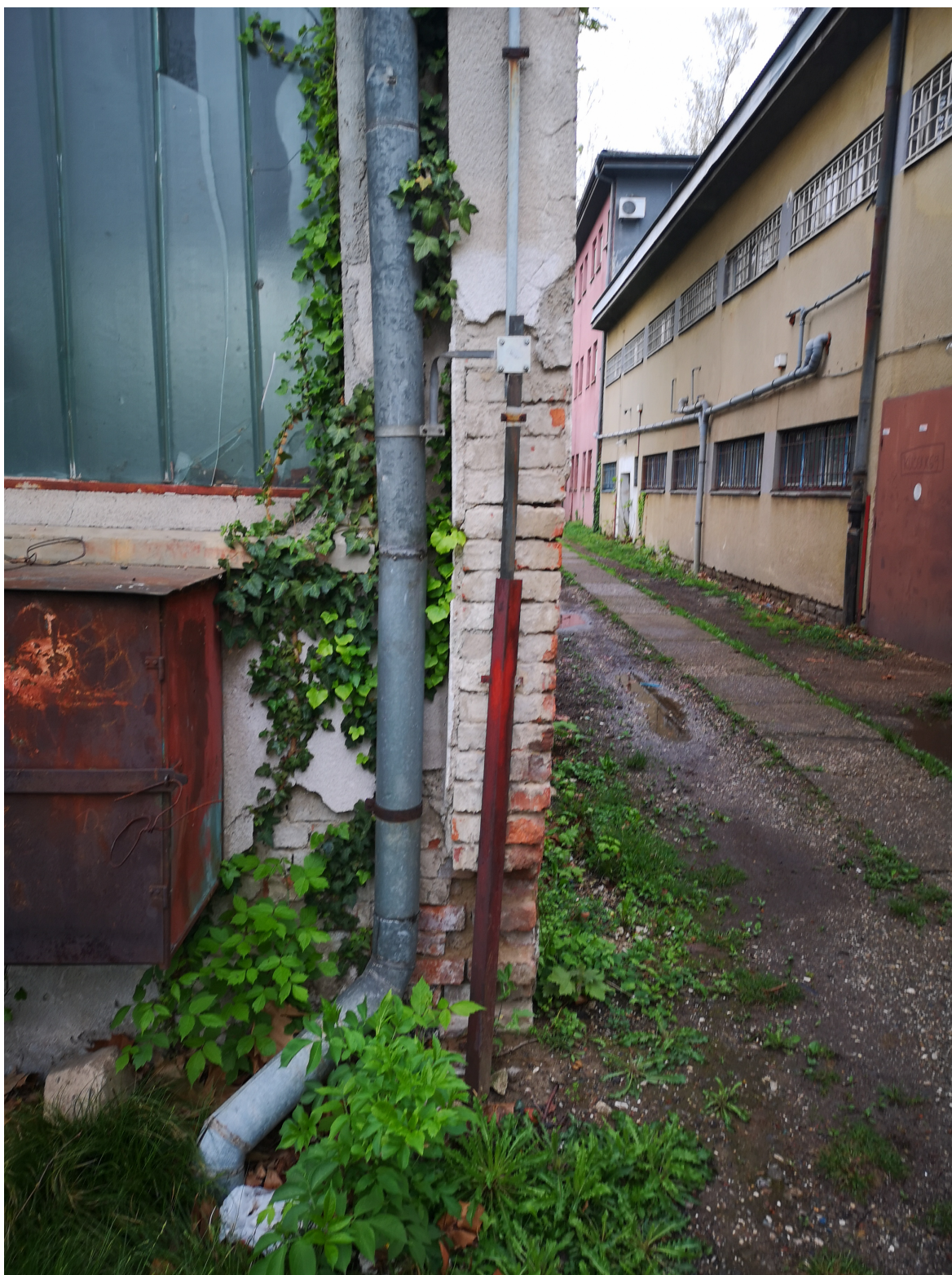
(zabatni zid koji je uslijed slijeganja pretrpio i deformacije tj. iskrivljenje)
