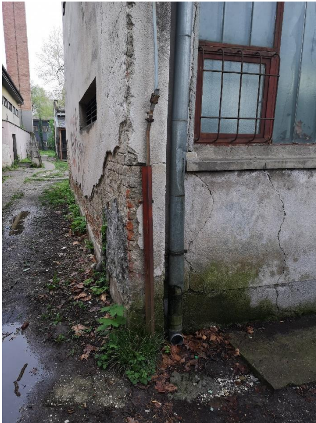
Slike 3 i 4: Detalji odvoda s mjernim spojem na radioničkom odjelu
