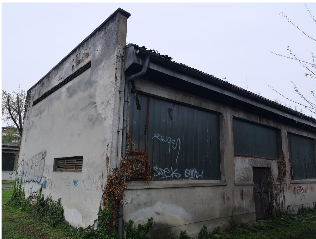
Slika 1: Pogled na radionički odjel sa zapada
