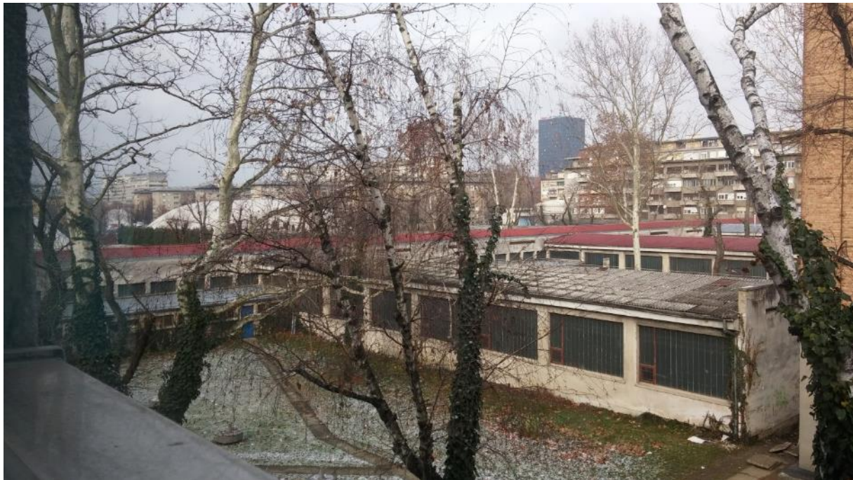
Prilog 2: Pogled na istočni dio radioničkog trakta škole
