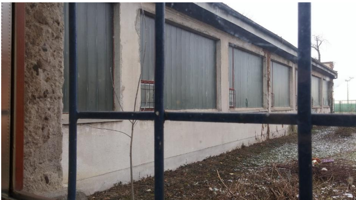
Prilog 3: Pogled na fasadu radioničkog odjela sa zapadne strane
